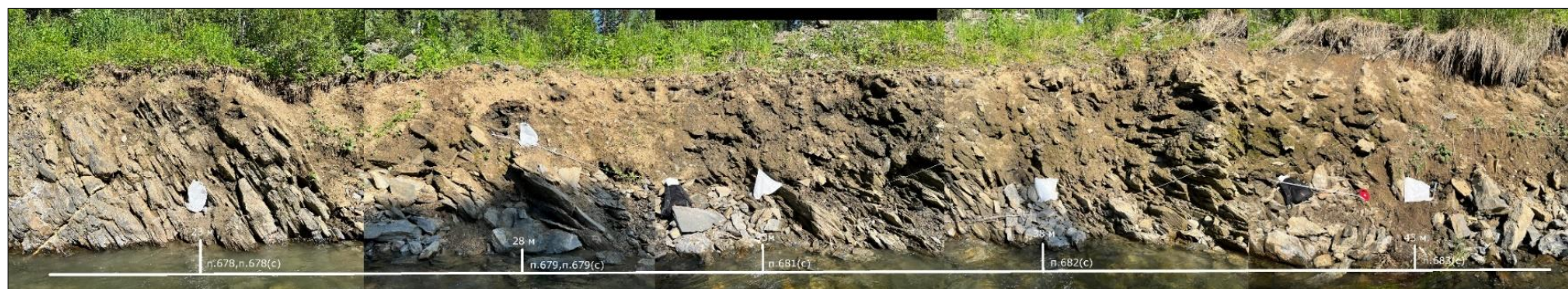
Рисунок 2 – Северная часть магистральной траншеи, начиная от устья ручья Миролюбивый
